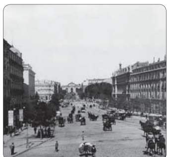
Alcalá, vista desde Gran Vía Año 1896
